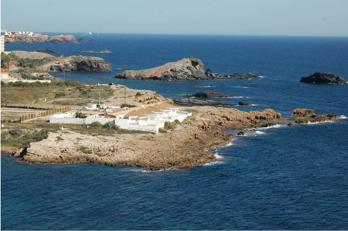
Fig. 1.- Panorámica de las edificaciones en Cala Reona.
